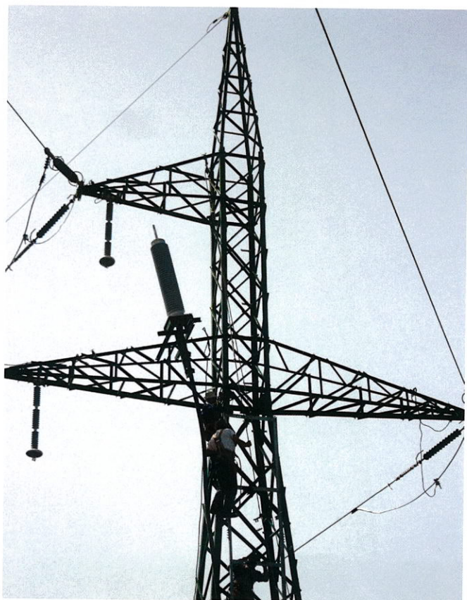
Рис. 16. Закрепление кабеля хомутами на опоре ВЛ
