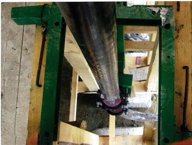
Рис. 11. Крепление кабеля под муфтой на металлоконструкцию до монтажа КМ
