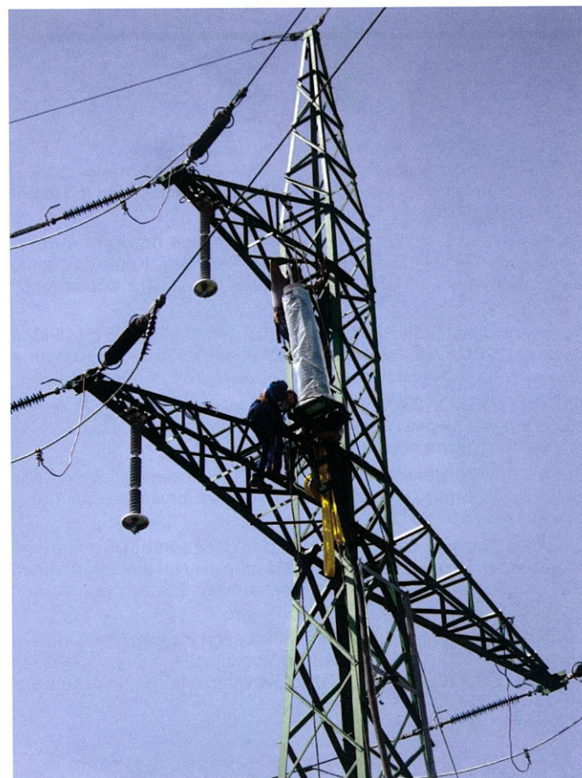
Рис. 15. Установка КМ с металлоконструкцией на место расположения на опоре ВЛ
