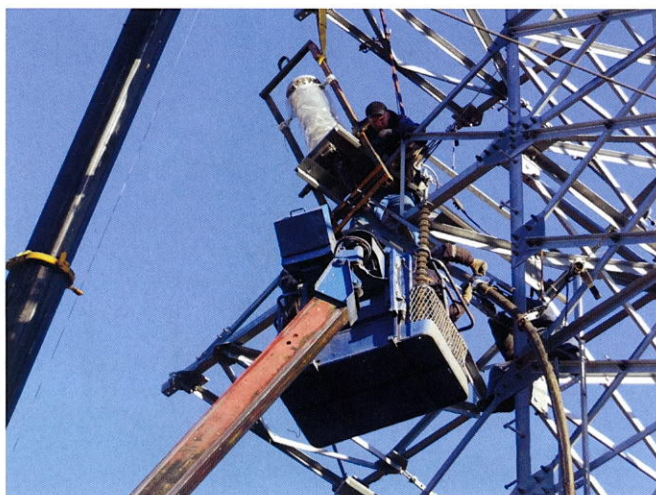
Рис. 8. Крепление кабеля под МКВ 126 на опоре ВЛ, перенос МКВ 126 с приспособления на место установки на опоре
