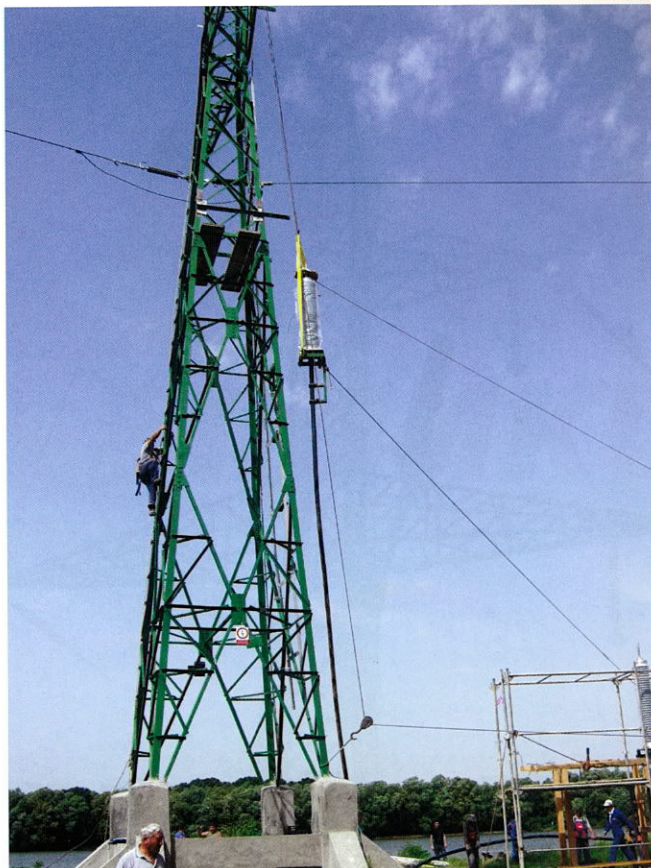
Рис. 14. Подъём КМ и кабеля, закреплённых на металлоконструкции, на опору ВЛ
