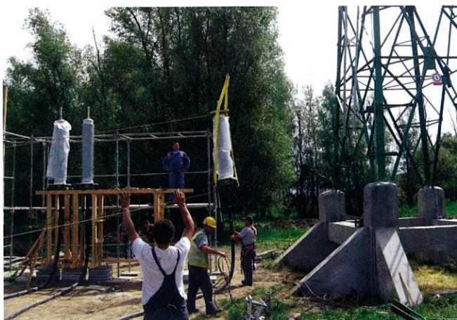
Рис. 13. Строповка КМ и кабеля, закреплённых на металлоконструкции
