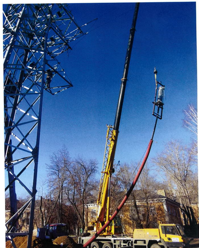
Рис. 7. Подъем МКВ 126, закрепленной на приспособлении, с помощью подъемного крана на опору ВЛ
