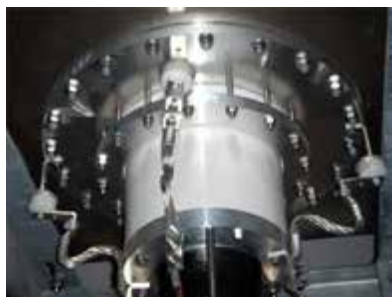
Рис. 13. Элегазовые вводы EHSVS 362-550 компании Südkabel GmbH со смонтированными ВЧ-заземлениями с ОПН вч. Вариант с креплением ОПН вч на ВЧ-заземлениях на медных уголках, закреплённых на промежуточном фланце
