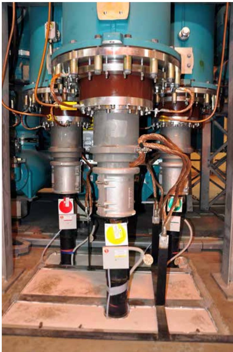
Рис. 10. Заземление элегазовых вводов APEGA 2454, смонтированных в КРУЭ 220 кВ фирмы Siemens на ПС «Матвеевская» (г. Москва)
