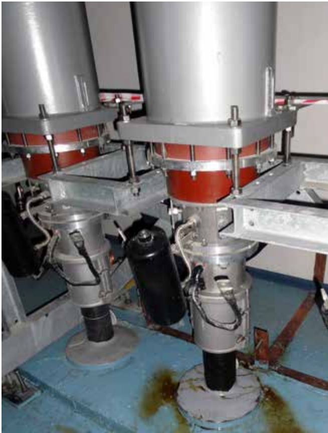
Рис. 20. Ремонтные работы на маслонаполненных элегазовых вводах EHSDV 123 производства компании Súd kabel GmbH. ПС «Чагино» (Москва, 2012 год)
