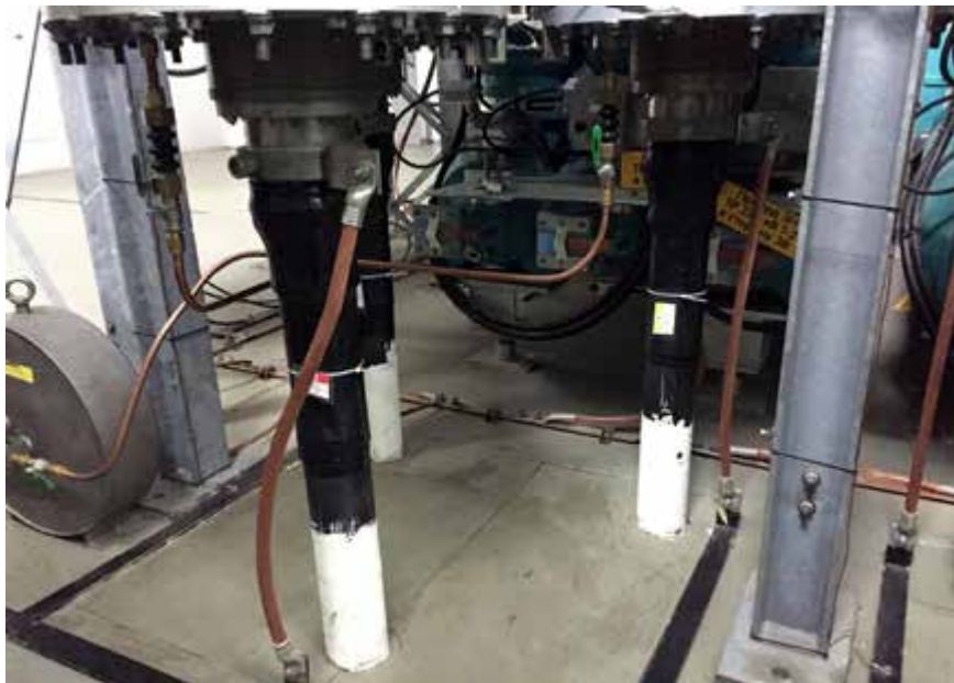
Рис. 22. Соединение медных трубок системы подпитки маслом элегазовых вводов SFMT-245 с баком давления, заземление проволок экрана кабеля на контур заземления
