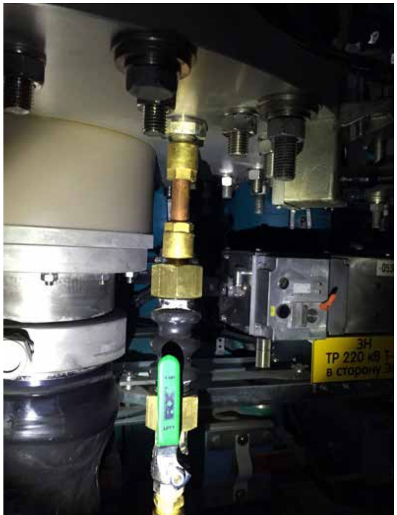
Рис. 23. Изолирующая трубка в системе подпитки маслом элегазовых вводов SFMT-245
